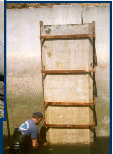
Form and pour concrete
